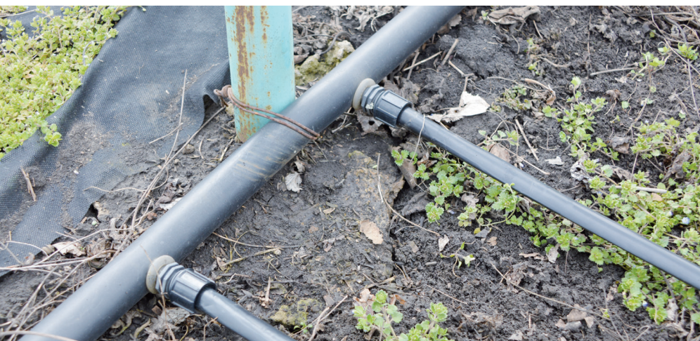
Места крепления старт-конекторов к магистральной трубе.
