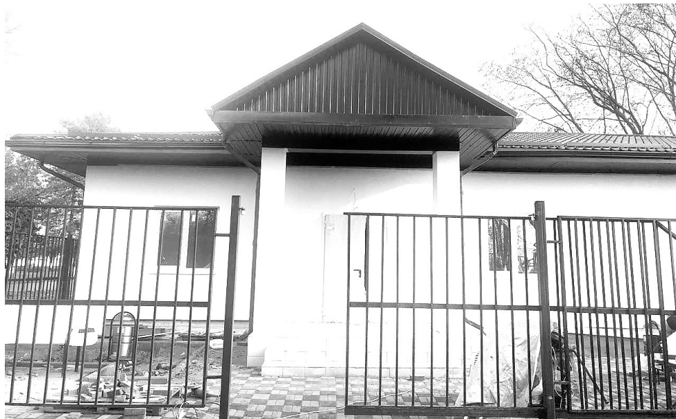
Строительство офиса врача общей практики в п. Прикубанском было выполнено в рамках партийного проекта «Здоровое будущее».
