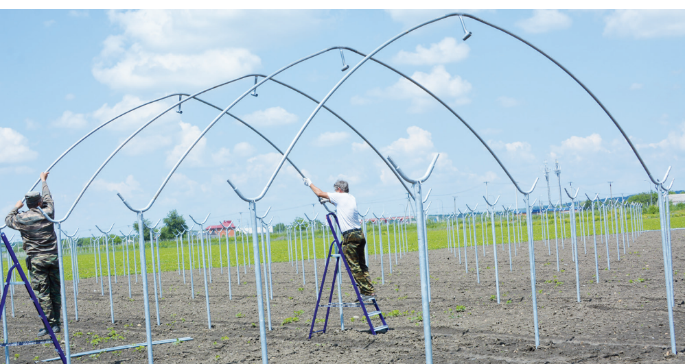
Идет монтаж монопролетных эвротуннелей для будущей плантации клубники.
