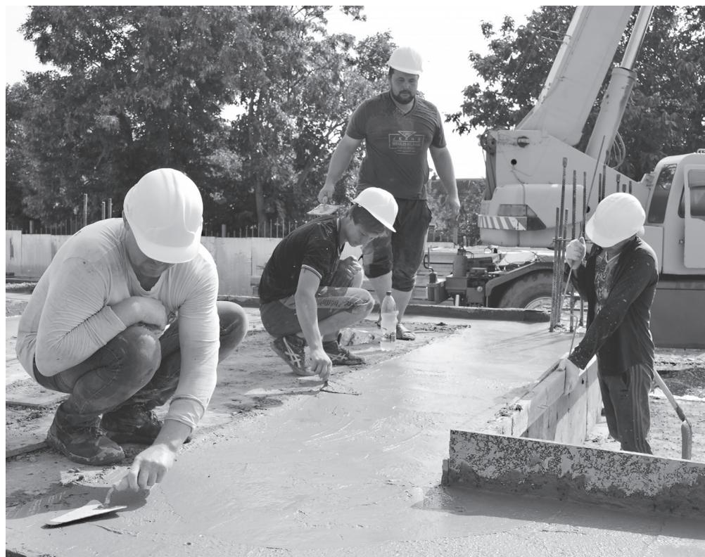
Рабочие строительной организации «Архстройсервис» выполняют бетонные работы по заливке конструкций первого этажа.
